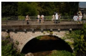
Ponte de pedra em forma de arco construída há mais de 80 anos na região de Takigahara
