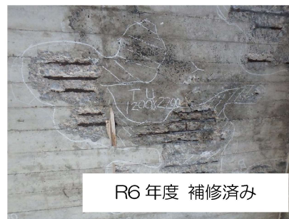
損傷例：コンクリート主桁の鉄筋露出
