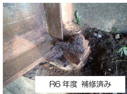
損傷例：支承の機能障害、腐食
