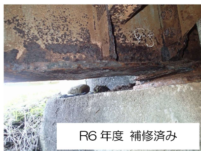
損傷例：橋桁の塗装のはがれ、腐食
