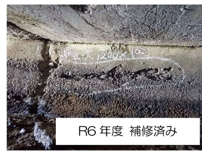
損傷例：下部工コンクリートの欠損
