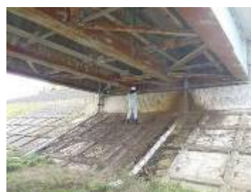
日常的維持管理（橋下面）
