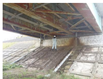
日常的維持管理（橋下面）
