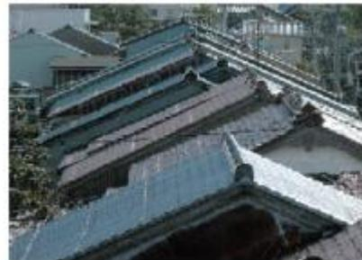
最上階に葺かれた屋根を小松では「大屋根」といい、2階と1階に葺かれた屋根を「小屋根」といいます。「大屋根」は、概ね3.5～4.0寸勾配に葺かれており、小松では統一した屋根勾配が見られます。
