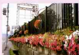
コマツ栗津工場の境界フェンス
