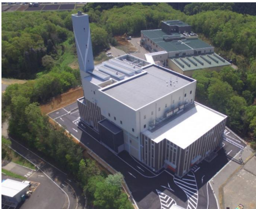
図 3-4-2 クリーンセンターの外観
