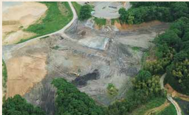
最終処分場 Landfill
