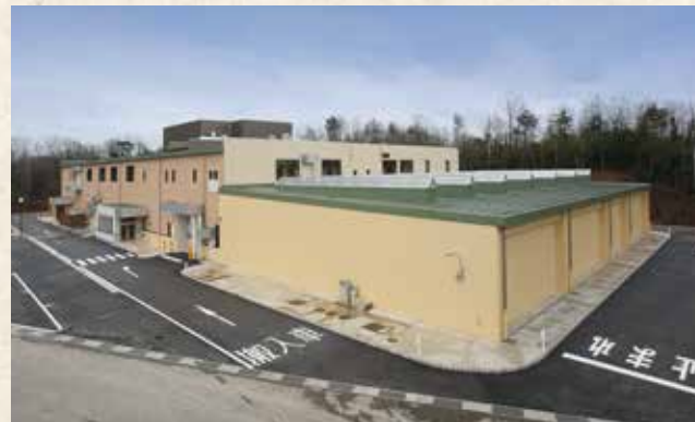
リサイクルセンター Recycling center
