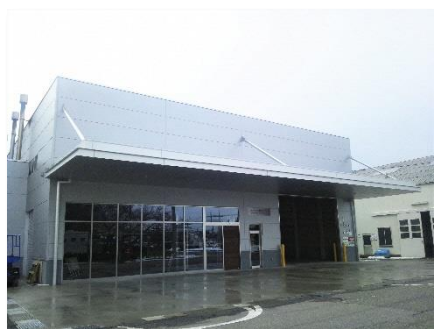
バイオマス※ボイラセンタ（コマツ栗津工場）
