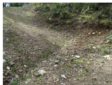
素掘りによる横断溝
