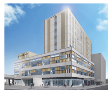
小松駅南ビルに大学開学
