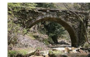
滝ヶ原アーチ石橋群東口橋
