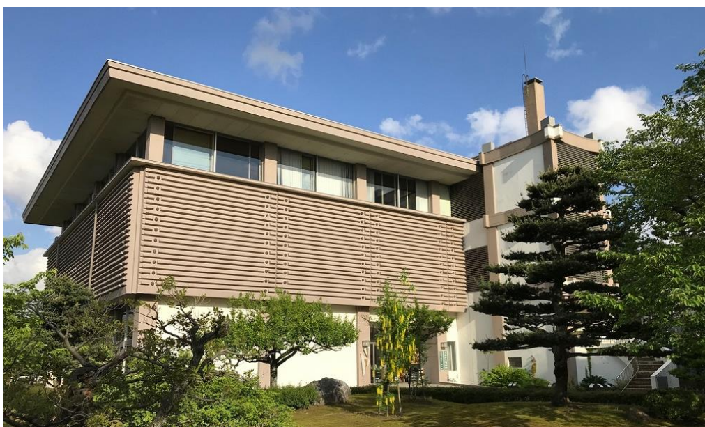
昭和45年に建設された小松市立博物館（2024.1 能登半島地震被災前）
