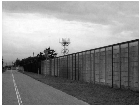
防音壁（市道浮柳串茶屋線自衛隊前交差点付近）
