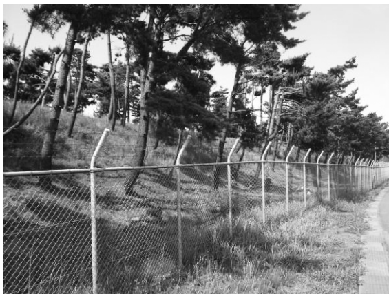
防音堤（市道浮柳佐美線・浮柳串茶屋線交差点付近）
